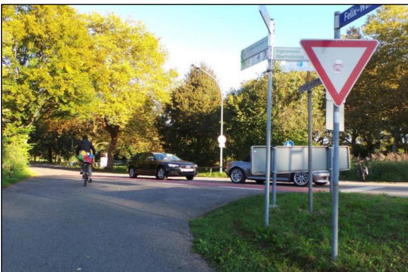
Abb. 43: Ungünstige Querungssituation für Radfahrer am Knoten BÜ Eichwald (Radfahrer muss im Rückstau des Bahnübergangs queren) – Maßnahme 010
