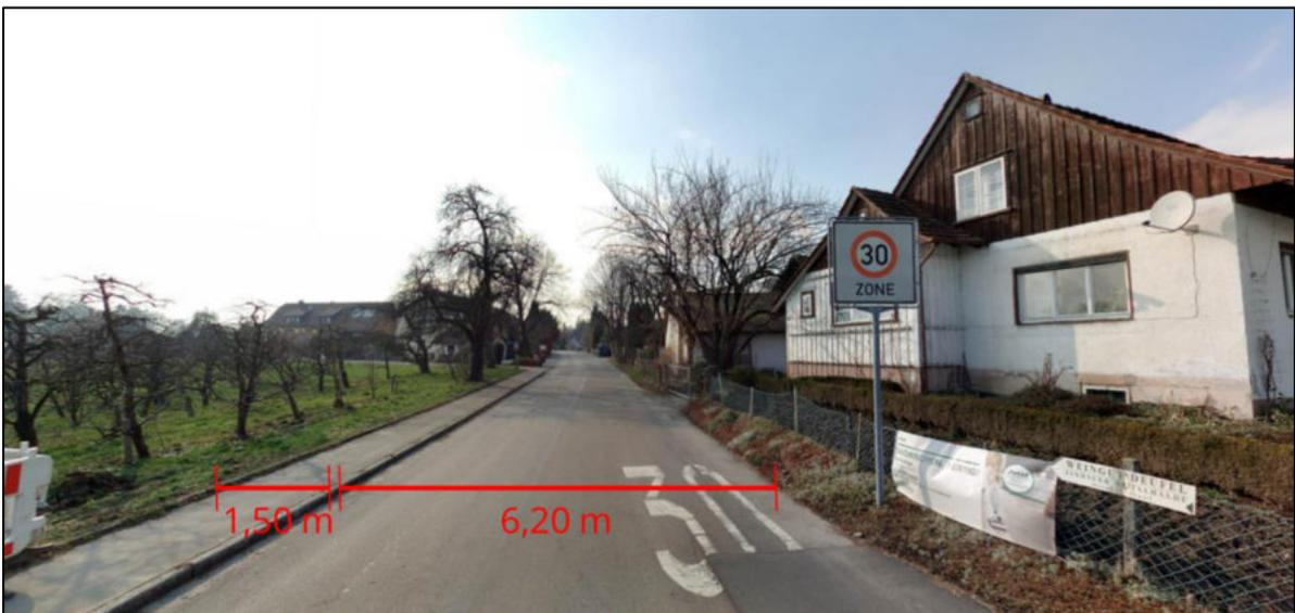
Abb. 29: Überbreite Fahrbahnquerschnitte im untergeordneten Straßennetz bieten Potenzial für Umgestaltung
