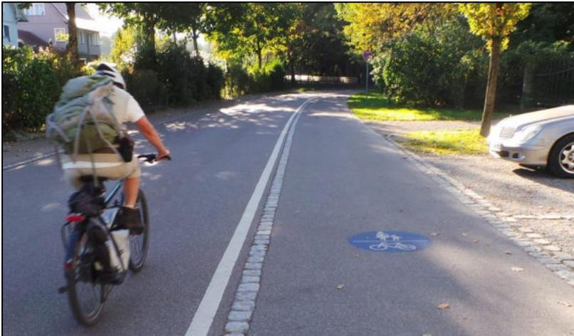
Abb. 44: Kurzer Abschnitt mit straßenbegleitendem Geh- und Radweg → häufige Wechsel der Anlagearten werden nicht befolgt und sind auch aus Gründen der Verkehrssicherheit zu hinterfragen (Maßnahme 013)
